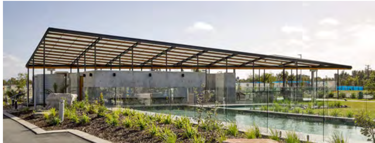
D. CONCRETE WALLS & STEEL FRAME PAREDES DE CONCRETO Y MARCO DE ACERO
