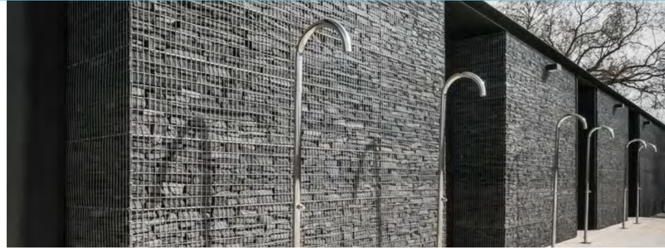
M. GABION WALL CONCRETE & STEEL MURO DE CONCRETO Y ACERO
