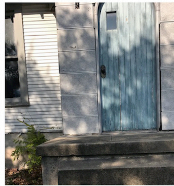
Asbestos Siding
