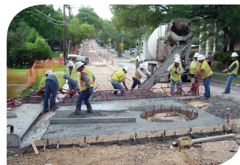
Reconstrucción de calles
