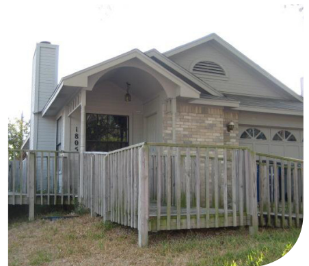
Reparación de casas-modificaciones para accesibilidad
