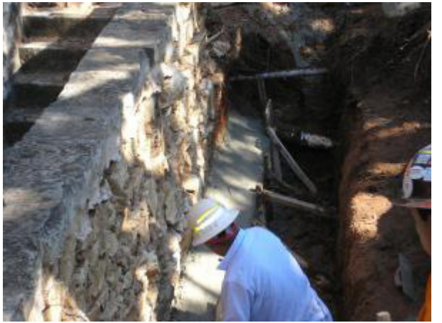
First concrete pour
