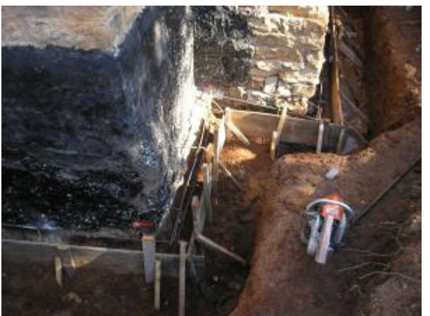
First concrete pour
