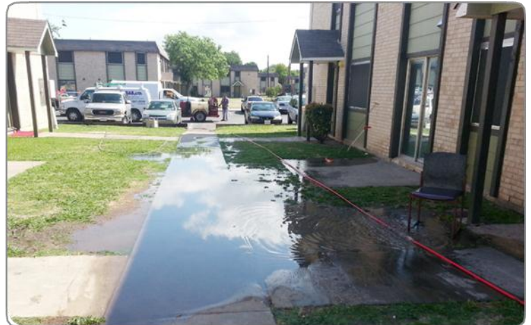
Desbordamiento de aguas residuales en un complejo de apartamentos en Austin.
