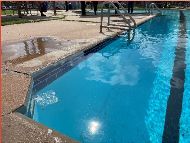
Concrete Shell Cascarón de concreto
