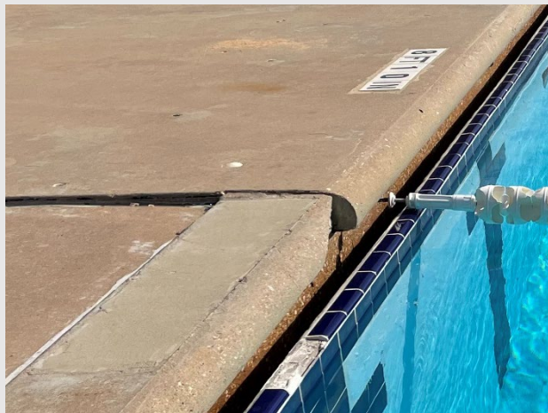
Concrete Deck Superficie de concreto
