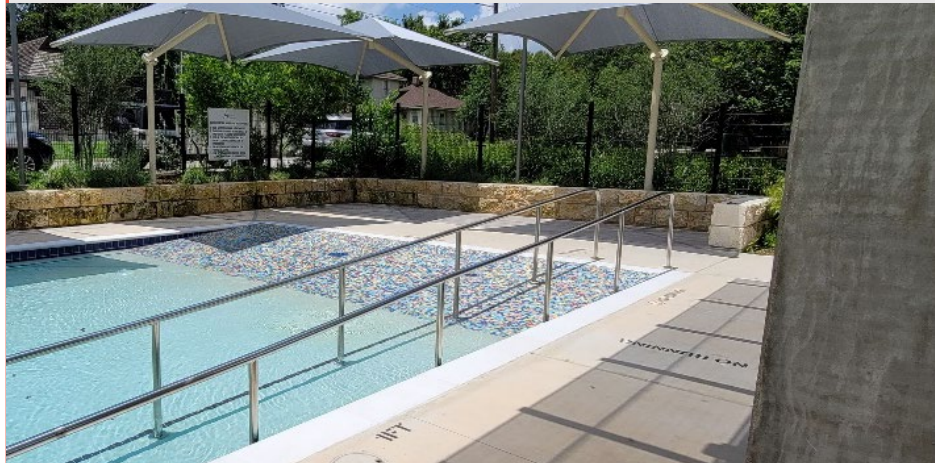
Zero Depth Entry (City of Austin Pool) Entrada de profundidad cero
