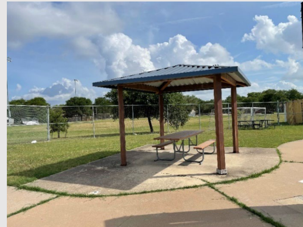
Metal Canopy at North Lawn Cubierta de metal
