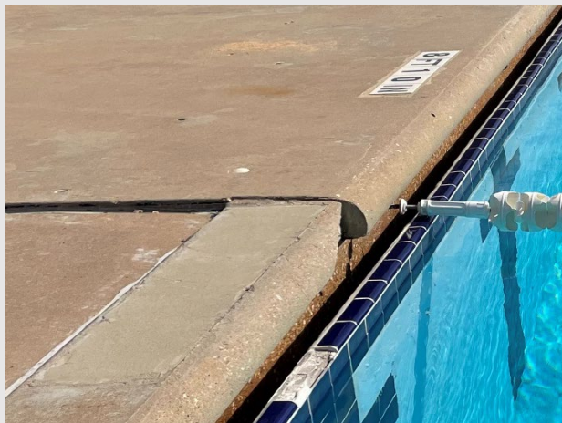
Concrete Deck Superficie de concreto
