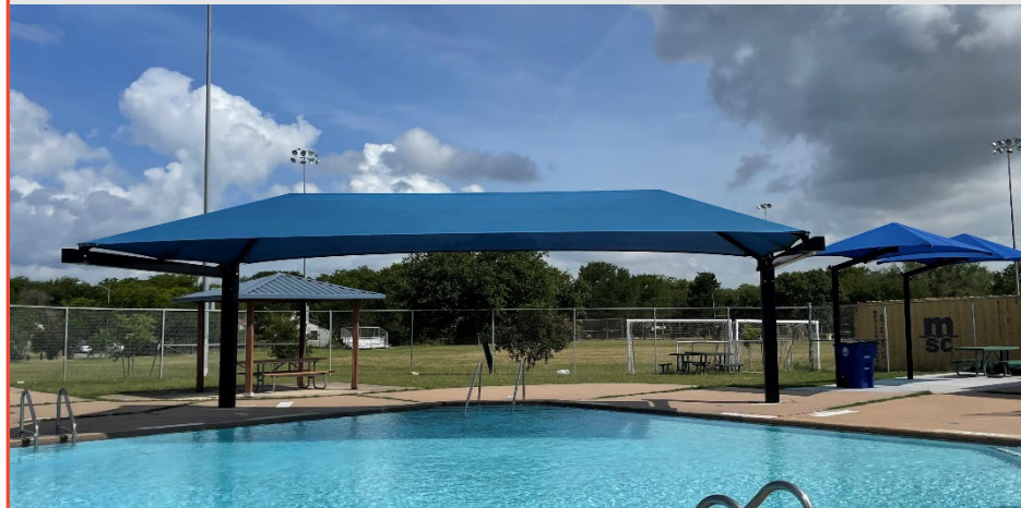
Shade Structures (Montopolis Pool) Estructuras para generar sombra
