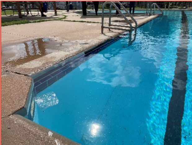
Concrete Shell Cascarón de concreto
