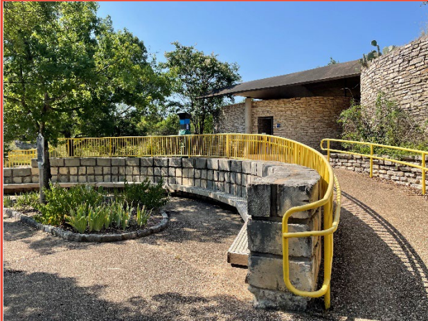
Entrance Ramp Rampa de entrada
