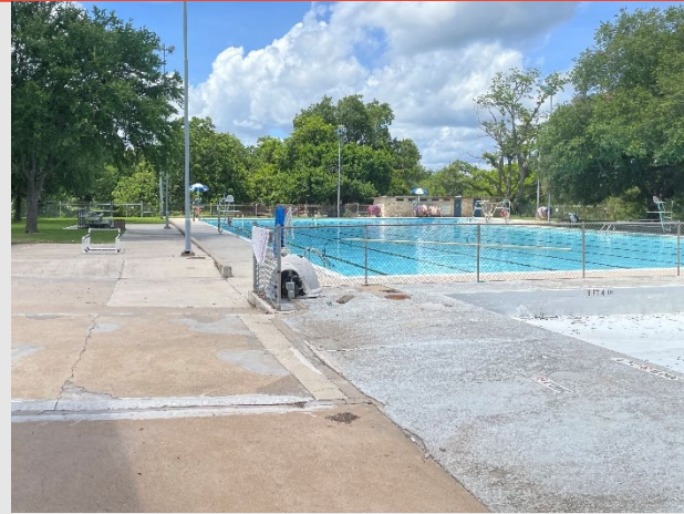
Concrete Deck Cubierta de concreto
