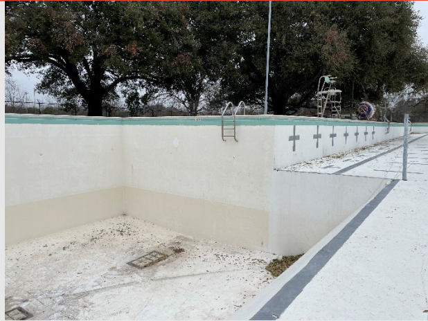
Concrete Shell Cubierta de concreto
