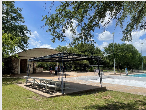
Metal Canopy at Kiddie Pool Estructuras metálicas
