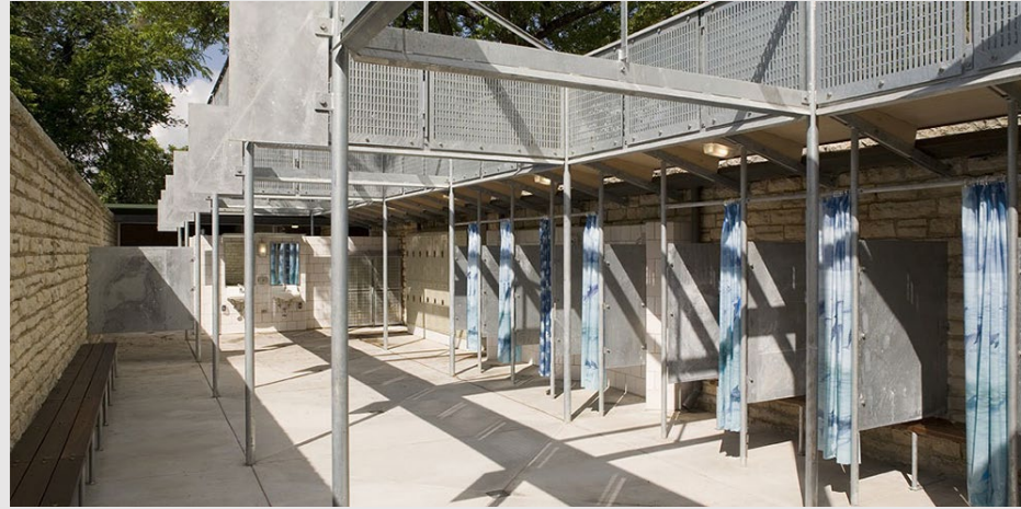
Changing Rooms (Deep Eddy Pool) Cuartos para cambiarse
