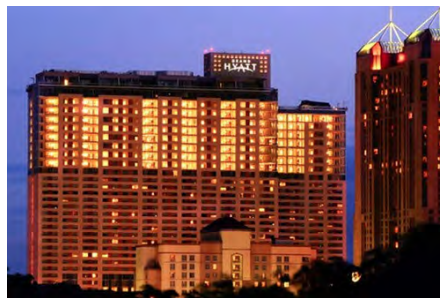
Alteza San Antonio, TX
