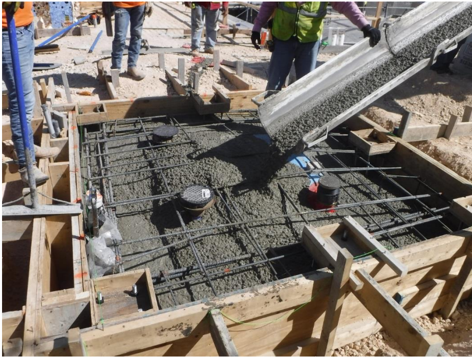
Concrete pour of bathhouse
