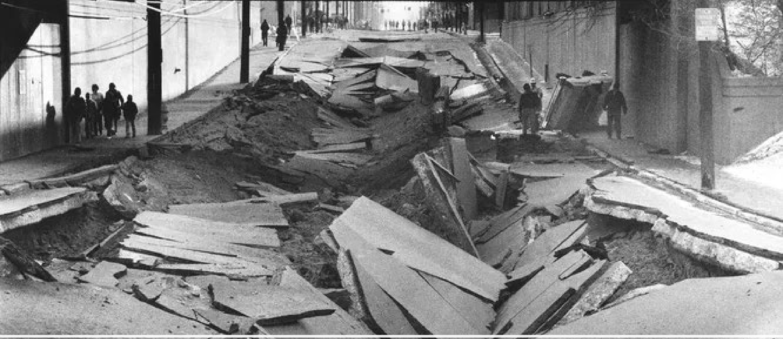
Seventh Street en Louisville: Explosión de una alcantarilla subterránea como consecuencia de la presencia de hexano en el alcantarillado; 13 de febrero de 1981
