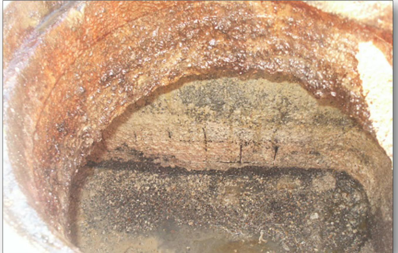
*Observe las líneas negras en la pared del tanque de la trampa que se muestra arriba. Es una barra de refuerzo de alambre expuesta.*
