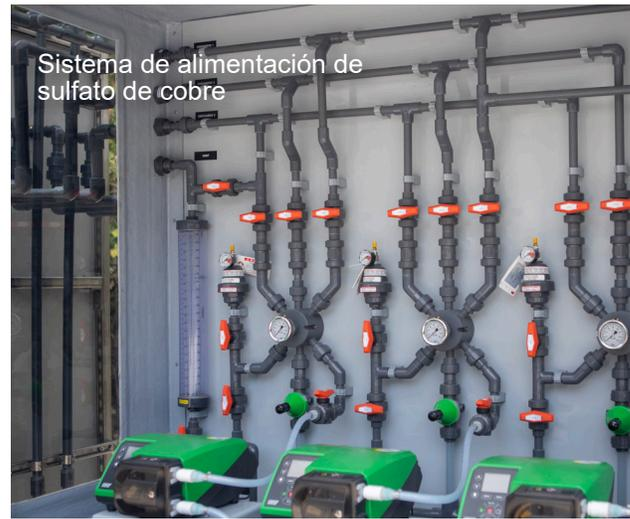
Sistema de alimentación de sulfato de cobre
